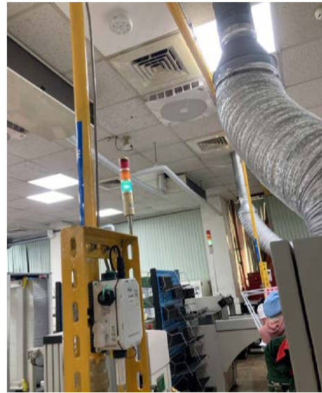
▲ 使用鋁軌和束帶固定於 2 台熔錫機旁的氮氣加壓管線上
