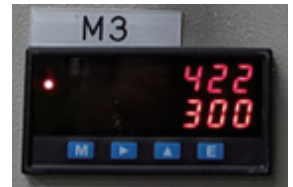
▲ 圖 4、可再外接一台數字型顯示器方便遠端人員監控
