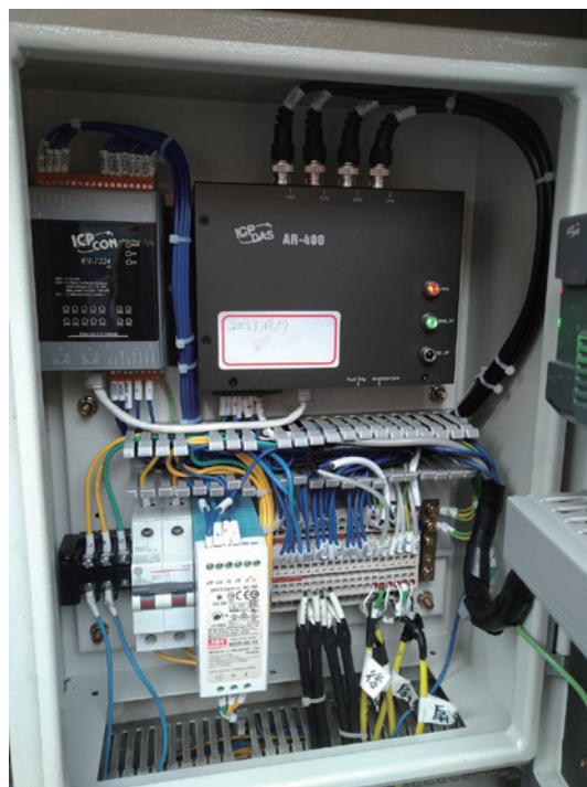
▲ 现场机柜安装
