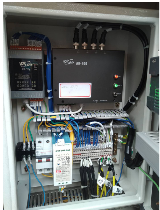
▲ 現場機櫃安裝
