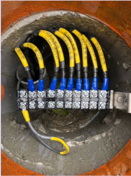
▲ 現場管道接線
