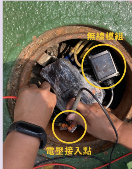
▲ 設備安裝情形
