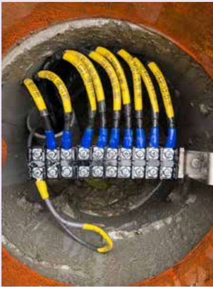
▲ 现场管道接线
