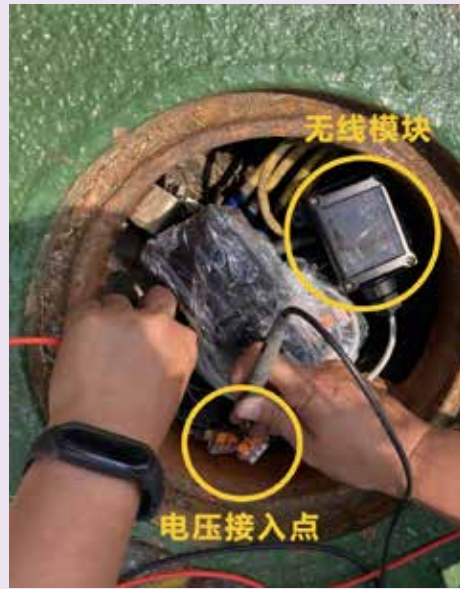
▲ 设备安装情形
