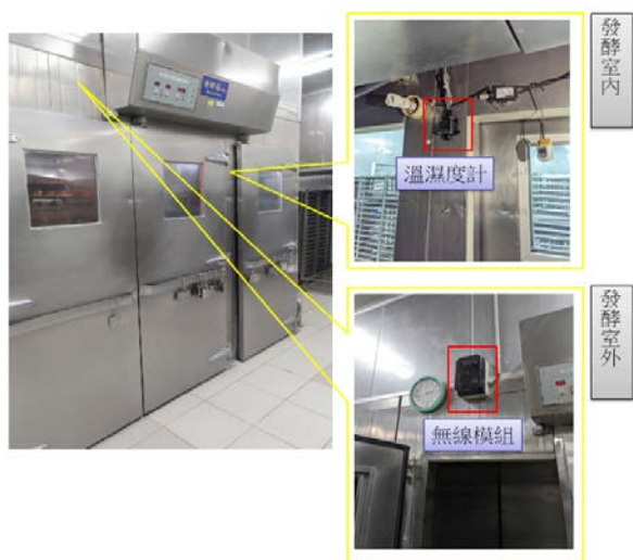
▲ 圖三 設備安裝情形
