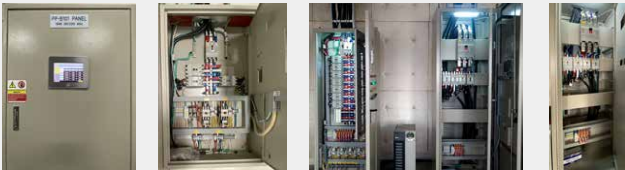
▲ 图二、电力监测现场配盘图
