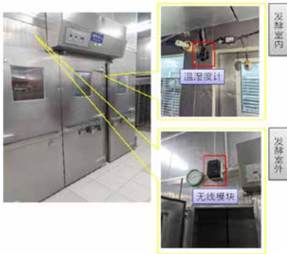
▲ 图三 设备安装情形
