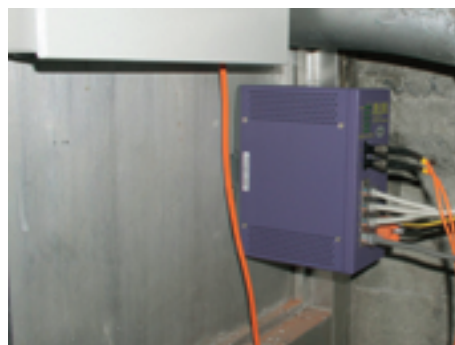
圖七、乙太網路光纖轉換器實裝圖
