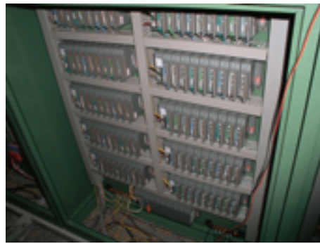
圖五、卡爾森型 (Carlson Type) 掃描模組實裝圖
