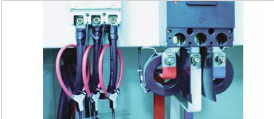
罗氏线圈 (Rogowski coil CT) 软式 CT 安装方式
