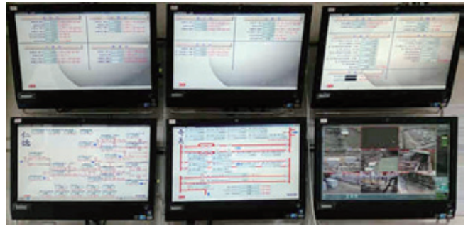
▲ 監控中心之所有整壓站集中監控畫面
