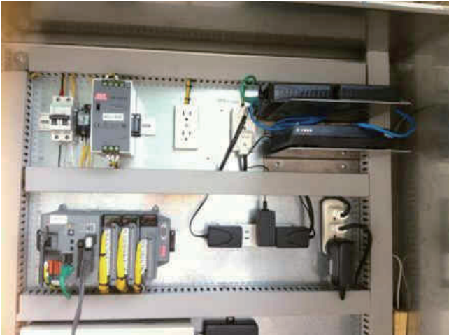
▲ 整壓站監控機箱
