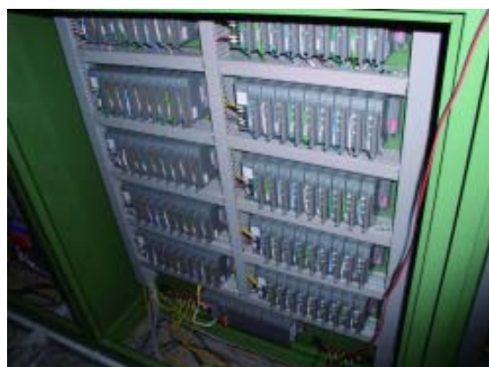
图五：卡尔森型模组安装图
