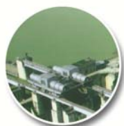
漏水量，混凝土温度计
